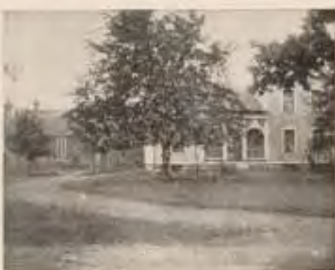
RESIDENCE OF F. M. HARMON.
