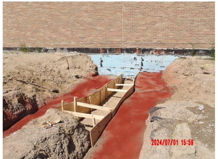
Concrete pour for new conduit runs
