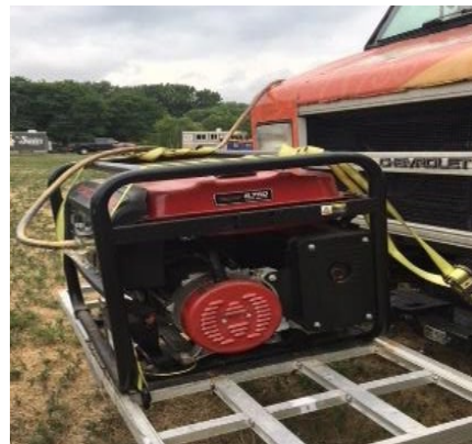
发电机安装在单位外部
