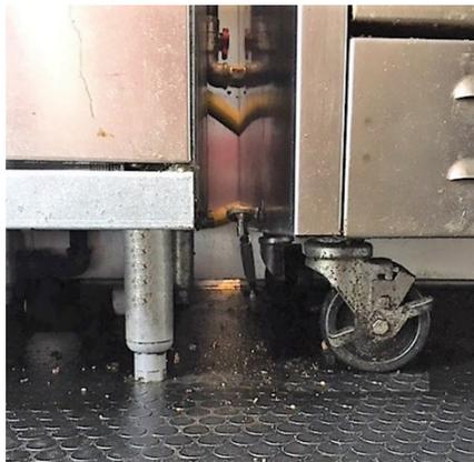
**Equipo montado en el suelo elevado sobre patas de 15 cm o sobre ruedas para desplazarlo para su limpieza.**
