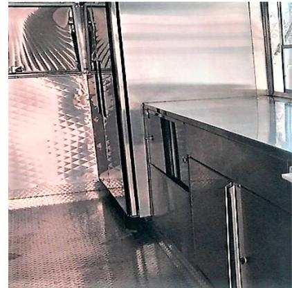
**Equipos sellados entre sí, al suelo y a la pared trasera para evitar que se acumulen residuos debajo, detrás y entre los equipos.**
