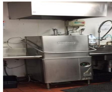
Campana de tipo II sobre lavavajillas que produce calor/humedad
