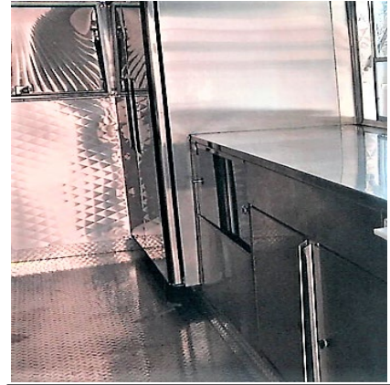
يتم إغلاق المعدات ببعضها البعض، والأرضية، والجدار الخلفي لمنع تراكم الحطام تحت المعدات وخلفها وبينها.
