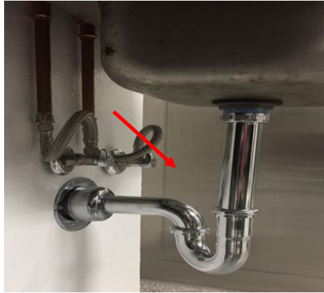
فاصل الهواء: خط الصرف أسفل حافة الفيضان لوعاء النفايات
