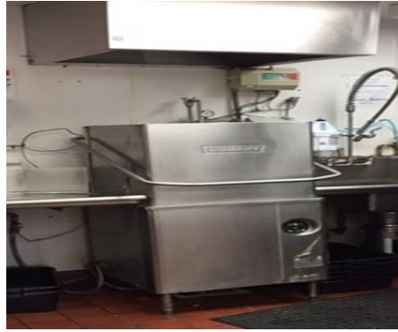
غطاء من النوع الثاني فوق آلة إنتاج الحرارة/الرطوبة
