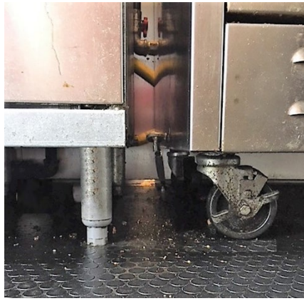
معدات مثبتة على الأرض مرتفعة على أرجل بمقاس 6 بوصات أو على عجلات لتحريكها أثناء التنظيف.
