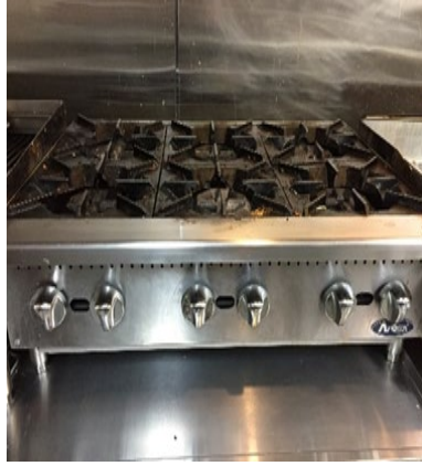
معدات سطح العمل مرتفعة على أرجل مقاس 4 بوصات لتوفير مساحة للتنظيف تحتها
