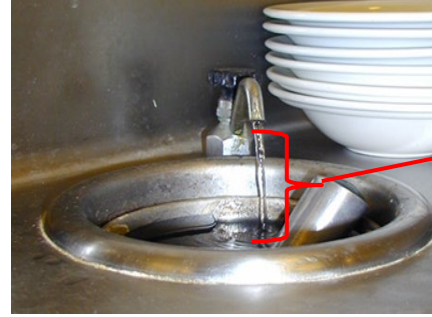
فجوة هوائية بين خط إمدادات المياه وحافة الفيضان للوعاء
